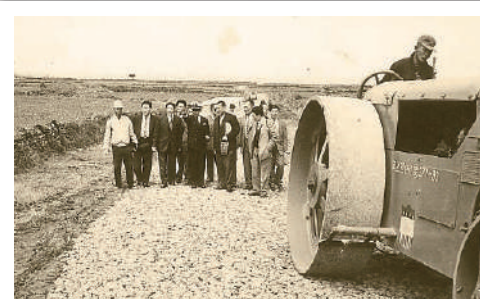
● 5.16道路工事現場を視察する訪問団一行
