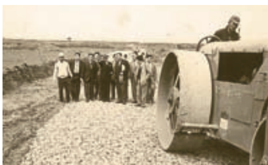
■ 5.16道路工事現場を視察する訪問団一行
