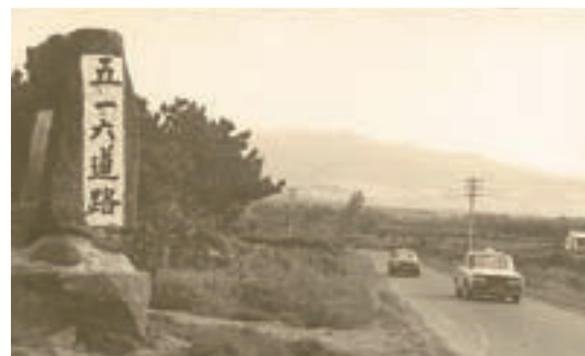
■ 念願の済州道一周道路の舗装工事が完了
